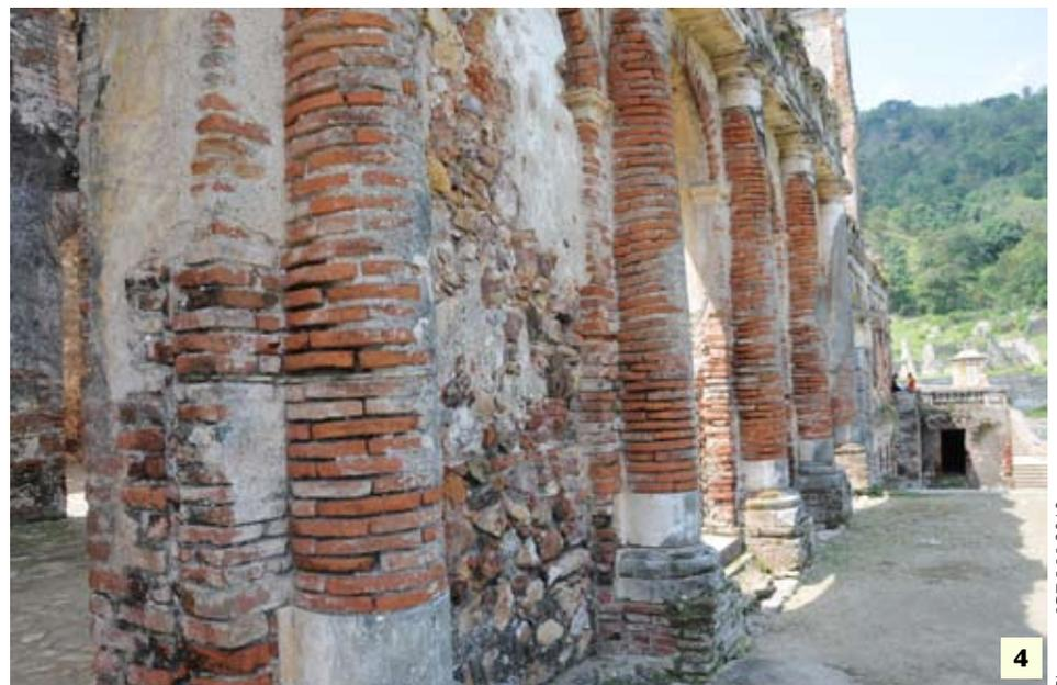
1. Le sol non imperméabilisé du Palais du Roi à Sans-Souci laissant infiltrer l'eau de pluie dans les fondations
