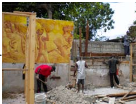
• La démolition de la fresque de Ramponneau
