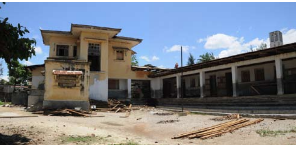
• La façade principale (est) de l'école des Garçons • Les élévations intérieures donnant sur la cour de récréation
