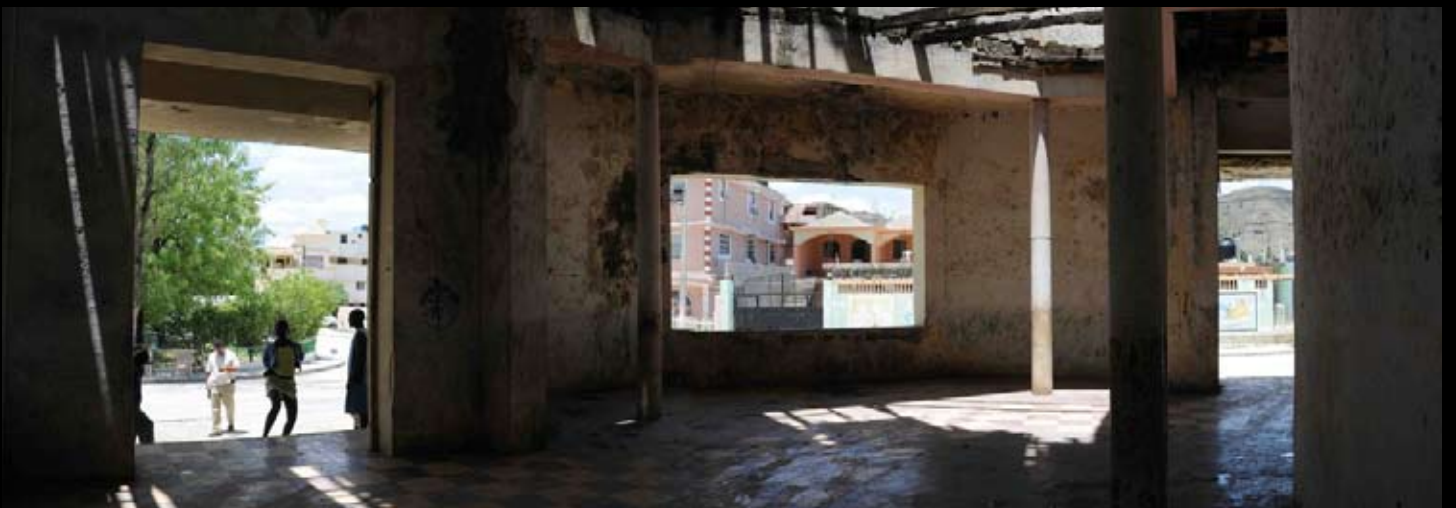
• Vue intérieure du Bazar . Le hall principal souvrant sur la vile
