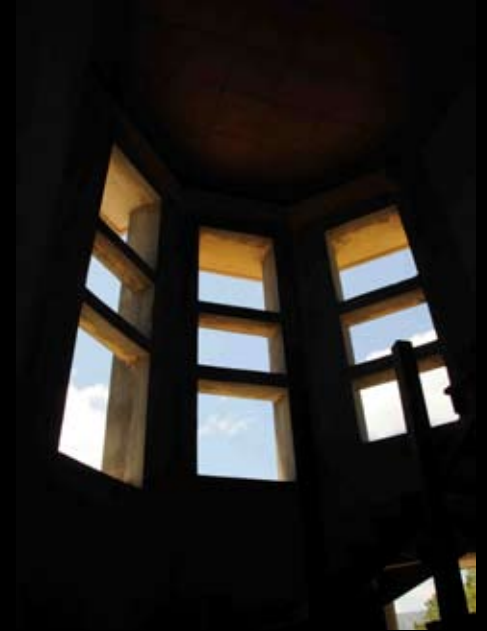
• L'agencement des baies de l'escalier de la Mairie
