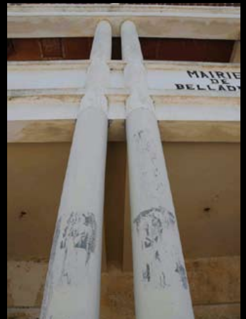
• La colonne double de la façade nord de la Mairie
