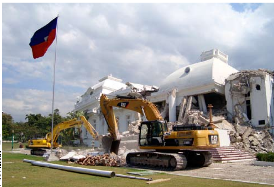
• Dépose des éléments irrécupérables
