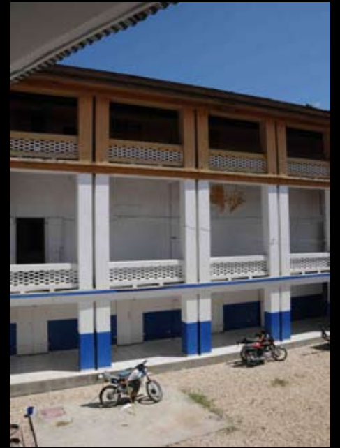
• La façade intérieure des Casernes
