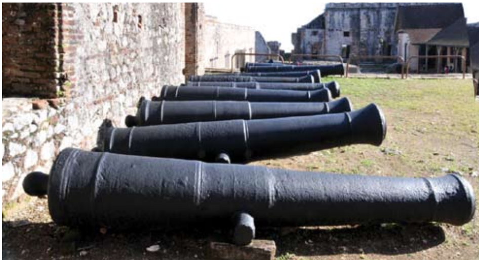
• Canons de fonte alignés sur la cour centrale de la forteresse
