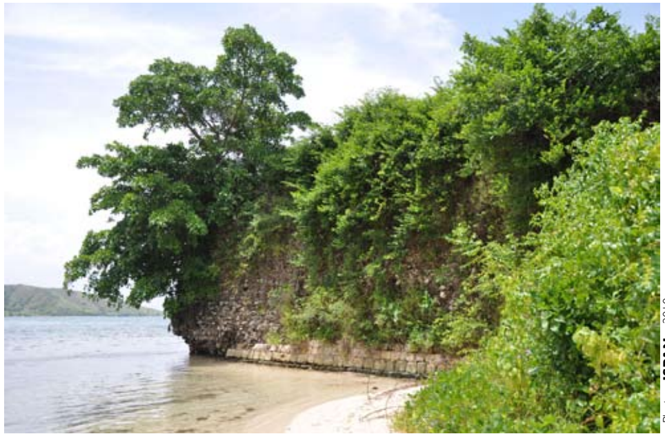
• Vue actuelle du bastion Saint-Philippe (bastion nord-est), couverte d'une épaisse végétation
