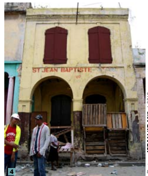
1. Les anciens magasins Estève (maison Tébo). 2. L'immeuble D'Adesky. 3 et 4. Halles de commerce, typique du Bord-de-Mer
