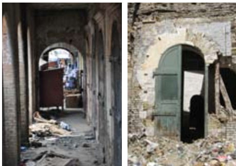
• Façades, galeries-trottoirs et porte à volets coupe-feu en métal
