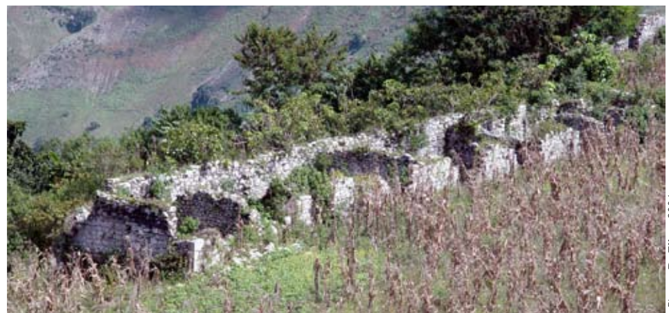
• Ruines des logements d'esclaves à l'habitation Séguineau (Fond-Baptiste, Haïti)
