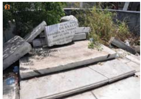
• 1. Le Monument-à-l'Empereur avant le séisme du 12 janvier • 2. Le monument démolé.
