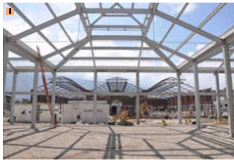
• Le chantier de restauration du Marché Hyppolite : au fond, la structure de la nouvelle halle nord, en avant-plan, la structure historique en cours de restauration
