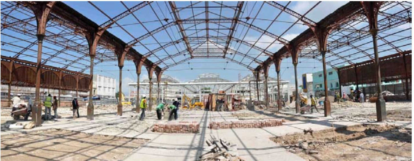
• Le chantier de restauration du Marché Hyppolite : au fond, la structure de la nouvelle halle nord, en avant-plan, la structure historique en cours de restauration
