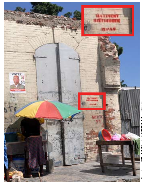
• Un bâtiment ancien du centre historique de Port-au-Prince scellé par l'ISPAN
