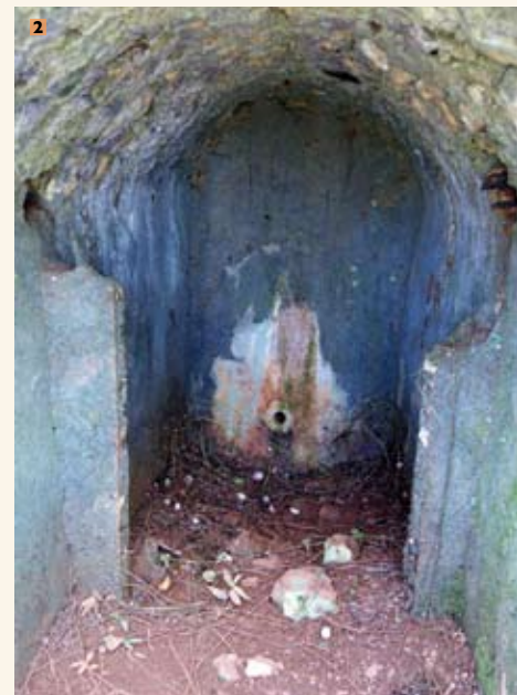
• 1. Le contrefort de la citerne • 2. La chambre de basse température adossée aux citernes • 3. Les entrepôts
