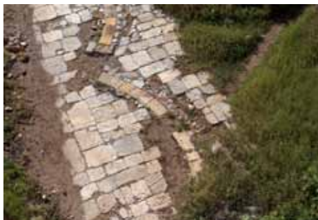
• Pavage en grès de Barzac des batteries
