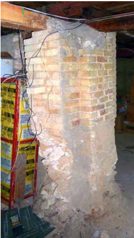
• 52 : Un espace sanitaire excavé au 84 de l'avenue Lamartinière laisse voir un ancien pilier hors sol en briques et son socle non enduit fait d'un mortier constitué de pierres calcaires et de terre crue.
