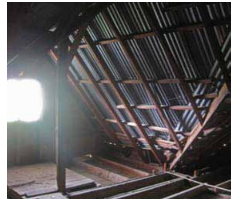
• 58 : La charpente en bois et l'espacement des pannes sablières de ce grenier ne peut accommoder qu'une toiture en feuilles de tôles ondulées, indication que les matériaux de ce toit sont des originaux.
