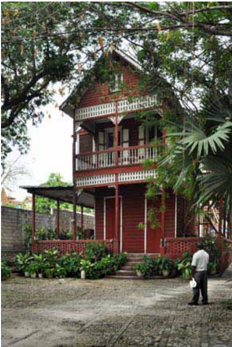
• 35 : Le 24 de l'avenue Lamartinière en bois de charpente,
