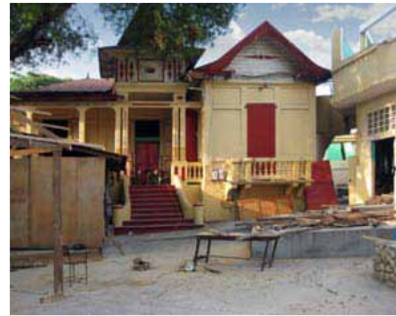
• 30 : Maison à charpente en maçonnerie masquant le style gingerbread . Unique variation remarquable de ce style qui n'a subi aucun dommage.
