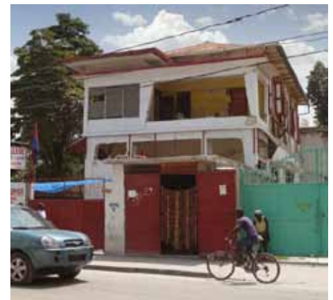
• 22 : Un ajout en ciment au no.4 de l'avenue Christophe dissimule complètement cette bâtisse qui perd ainsi son identité originale de maison gingerbread.
