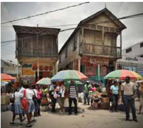
• 19, a, b, c, d : Utilisation à des fins non résidentielles de bâtisses gingerbread; ci-dessus, le Collège des Jeunes Filles au 10 de la 1ère Impasse Lavaud; en haut à droite l'Hôtel Oloffson, hôtel depuis 1936, a été un hôpital militaire américain de 1915 à 1935; à droite le 84, avenue Lamartinière, est en train d'être rénové pour être réaménagé en restaurant; en bas deux immeubles en bois de l'avenue John-Brown typiques, avec espaces commerciaux au rez-de-chaussée. Tous ces modèles sont emblématiques de l'architecture vernaculaire haïtienne dérivant des maisons style «fusil de chasse» longilignes et étroites, avec murs à pignons et des pièces de la largeur du bâtiment.
