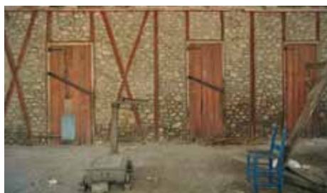
• 25 a : Grange à Léogâne. Exemple de colombage à moellons renforcé avec des roches ignées plus solides que celles utilisées à Port-au-Prince, et sans stuc.
