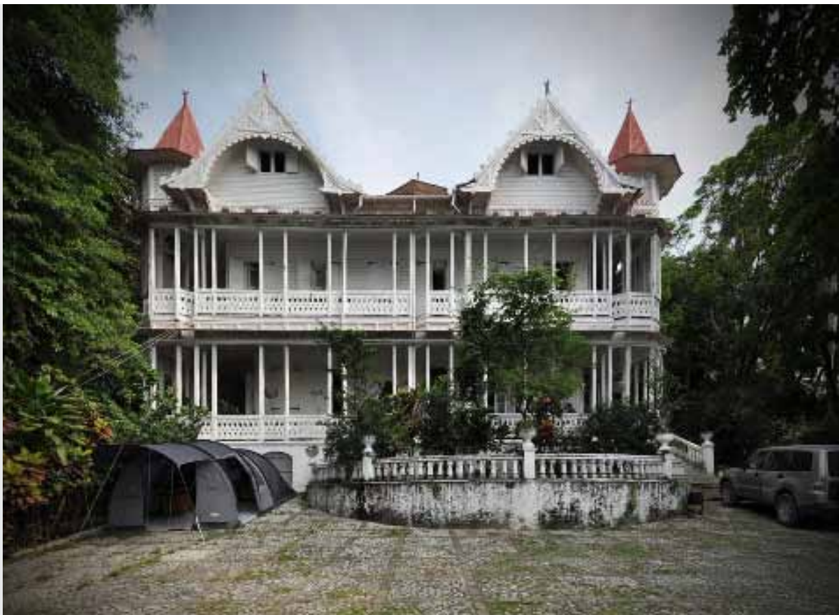
• 15 : La maison Peabody à Pacot datée de 1912. Cette maison à colombage et charpente en bois n'a pratiquement pas été endommagée par le séisme.
