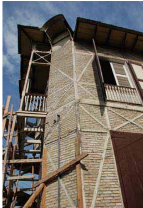
• 42 : Maison située au 32 avenue Lamartinière. La charpente en bois entretoisée et briques de hourdage est un élément important de l'architecture vernaculaire.
