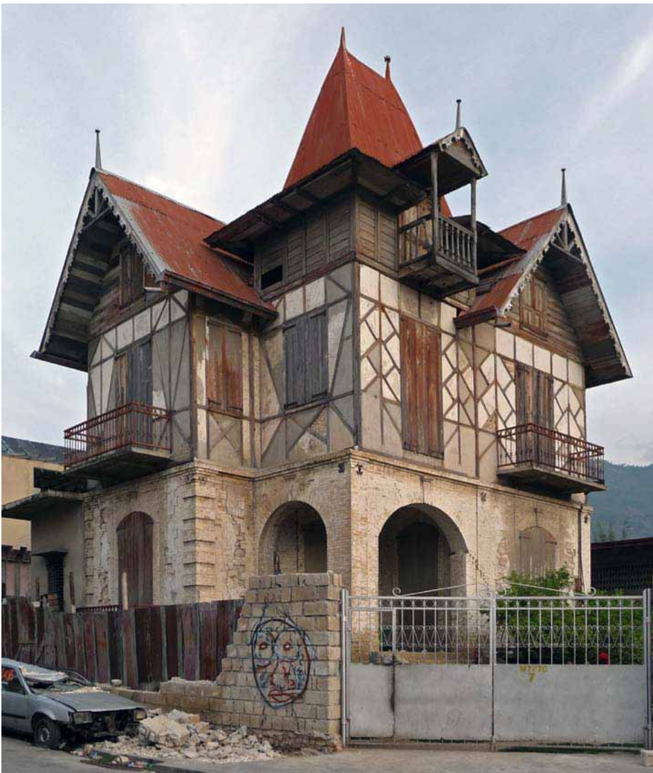
• 49 : Les architectures hybrides sont très courantes. Cette maison gingerbread au 59 de la troisième Impasse Lavaud utilise les trois techniques de constructions de murs:
