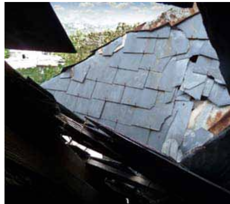
• 57 : Toiture originale en ardoises minces au 14 de l'avenue John Brown.
