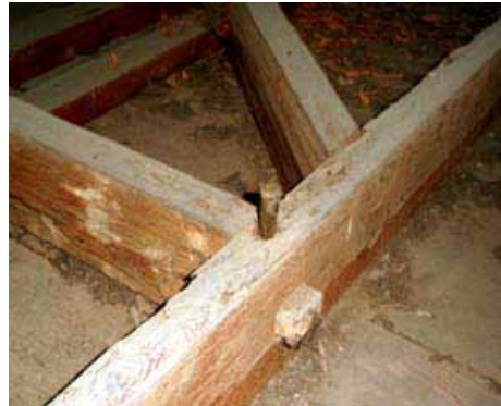
• 53 : Charpente des combles en bois assemblés en mortaise et tenon retenus par des chevilles en bois.
