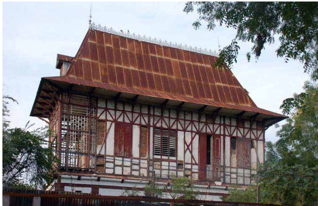
• 55 : Les toits en métal ferreux sont très courants dans les maisons gingerbread. Cette maison a également une crête en métal sur la corniche.
