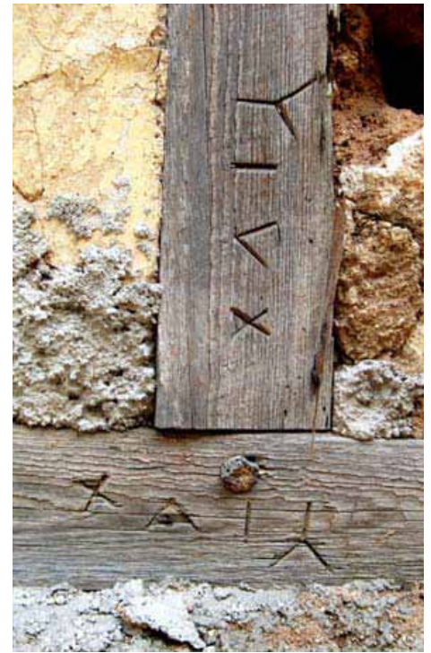
• 37 : Détail d'une maison à colombage. La charpente en bois est retenue avec une cheville de bois et les cavités des parois sont remplies de pierres et d'un torchis de chaux. Le remblai de gauche composé d'argile et de stuc est toujours en place. A noter la marque du menuisier gravée dans les bois de la charpente.
