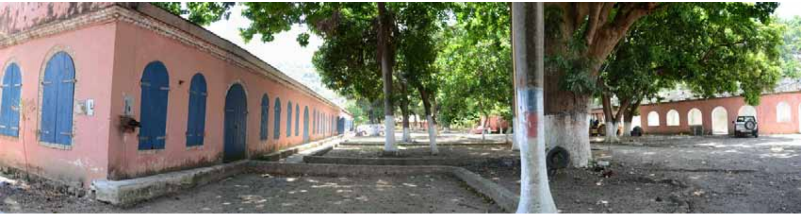
• La cour centrale de l'ancien pénitencier du Cap-Haïtien. À gauche le bureau régional Nord de l'ISPAN
