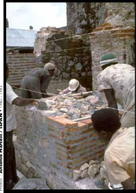
• Travaux de restauration du Quartier des Officiers et de la Batterie Royale
