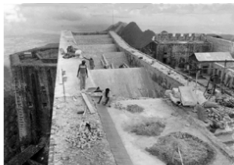
• Travaux d'étanchement de la Batterie Marie-Louise
