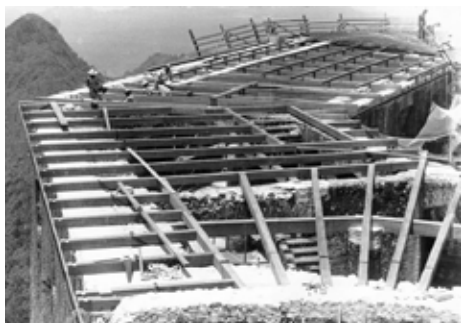
• Charpente de la toiture "provisoire" de la Batterie Coidavid
