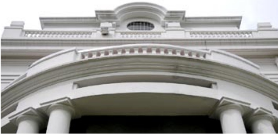
• Détail de la façade est du Palais National
