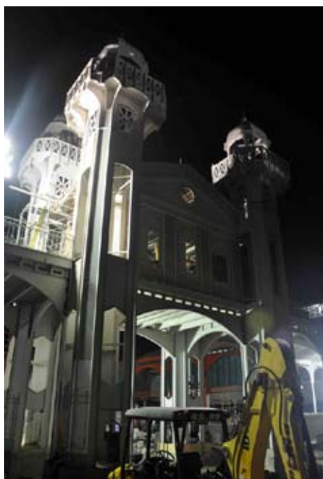
• Le chantier de restauration, la nuit
